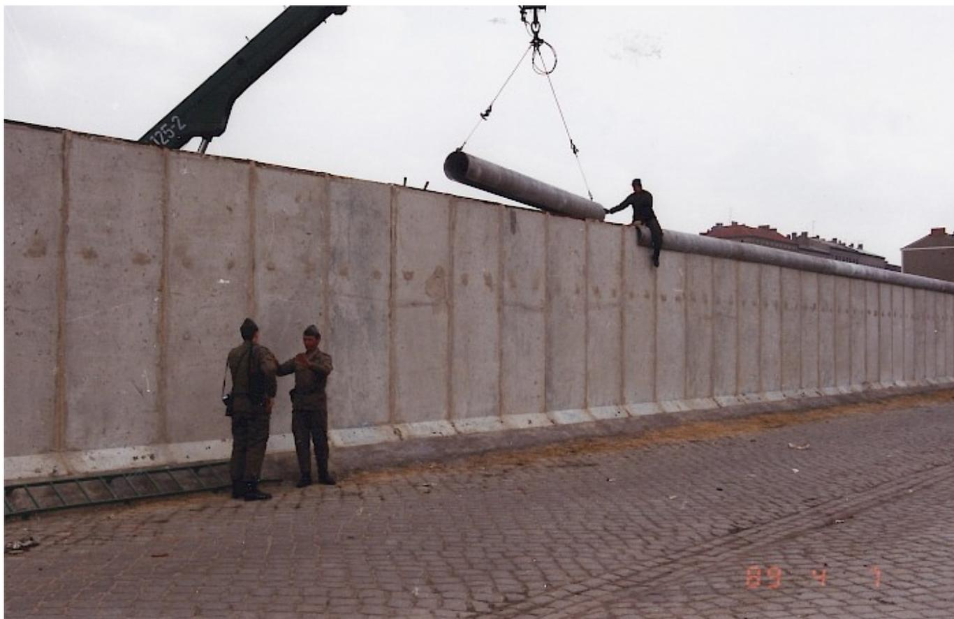
Mit Hilfe eines Krans wird eine Rohrauflage auf die Mauerelemente der Grenzmauer 75 gesetzt. Davor stehen zwei Grenzaufklärer. Diese Phase des Ausbaus ist die letzte vor dem Mauerfall.
