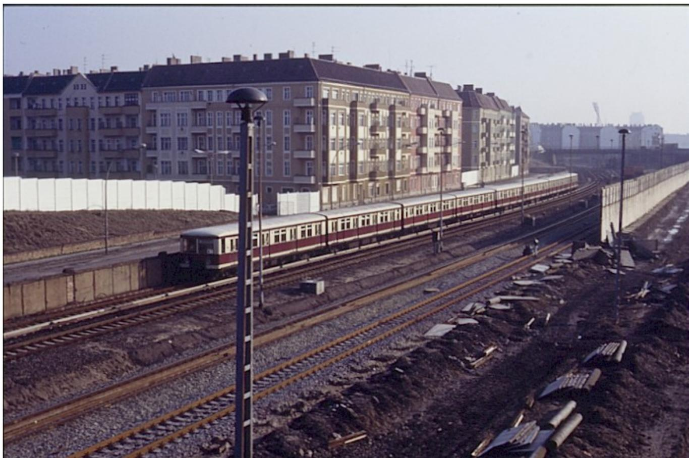
Beseitigung der Grenzanlage südlich der Bösebrücke. Auf dem Boden liegen Mauerelemente wie Rohrauflagen und Betonplatten.
