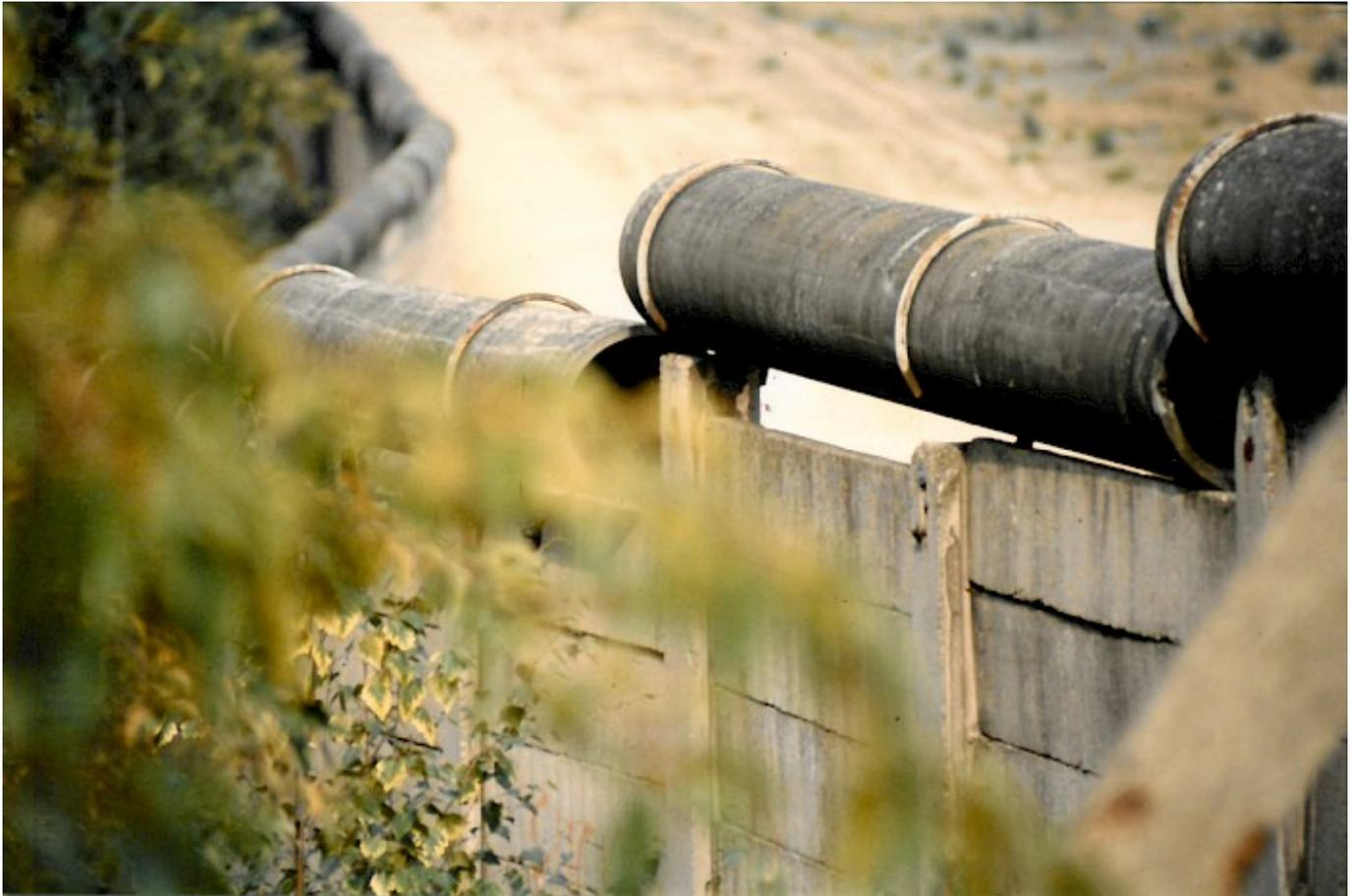
Nahaufnahme der Rohraufgabe und Betonplattenmauer talabwärts bei Lübars, im Hintergrund ist der Grenzstreifen sichtbar.
