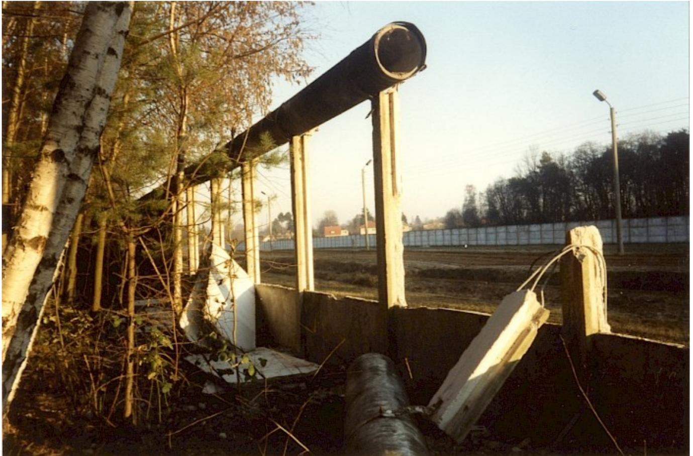
In der sogenannten "Nachtbucht", einem kleinen Wäldchen am Rand von Lichtenrade, sind bereits einige Mauerelemente aus der Betonplattenmauer herausgebrochen. Nur die Rohrauflage ist noch intakt. Im Hintergrund ist die Siedlung Mahlow-Waldblick zu sehen.
