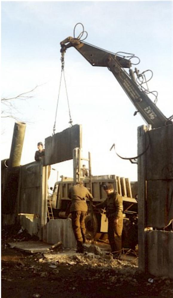
Angehörige der Grenztruppen arbeiten am Außenring bei Lichtenrade. An einem Arm eines Baukrans wird gerade eine Betonplatte in die Verankerung gehoben, dahinter steht ein LKW.
