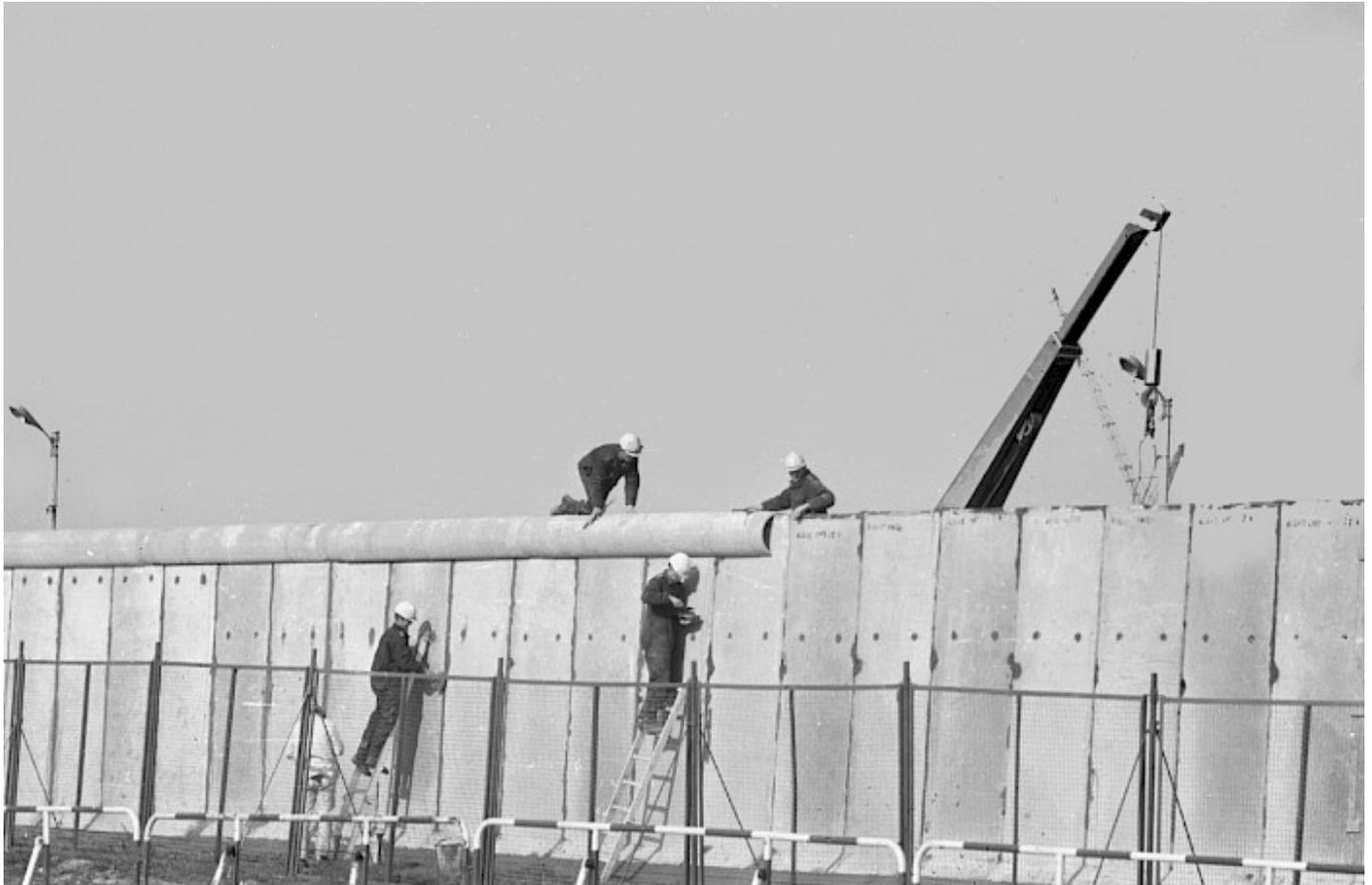
Angehörige des Bautrupps verputzen, auf Leitern stehend, die Grenzmauer. Weitere Bauarbeiter befestigen die Rohraufgabe auf der Mauer. Ein mobiler Sicherungszaun und Absperrgitter stehen vor der Baustelle. Hinter der Grenzmauer ist ein Kran zu sehen.
