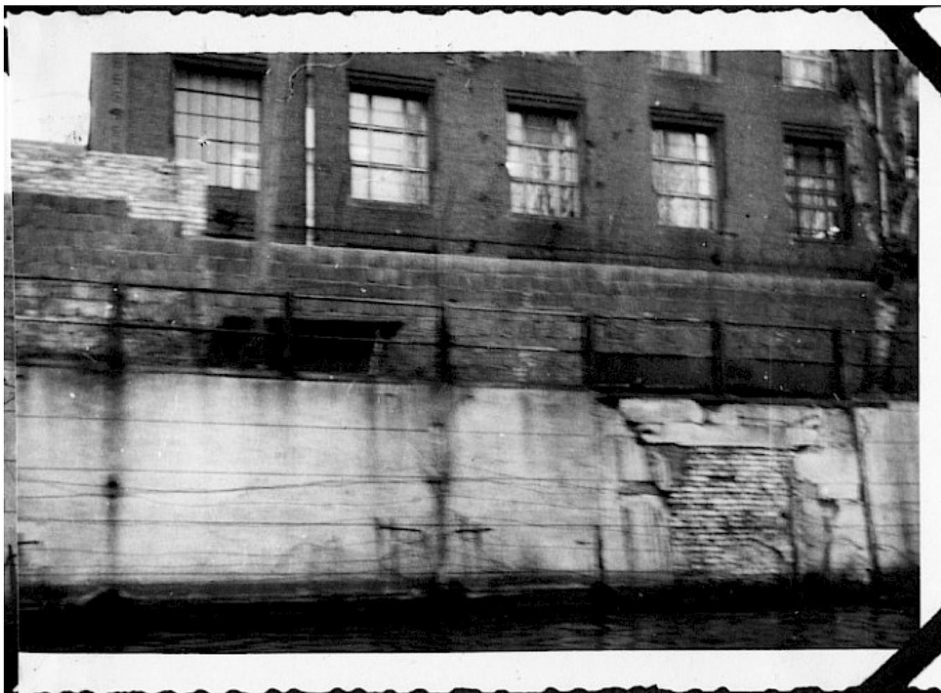
Grenzmauer am Ostufer der Spree an der Schillingbrücke. Sie besteht aus einer Betonverbundmauer mit beidseitigen Abweisern.
