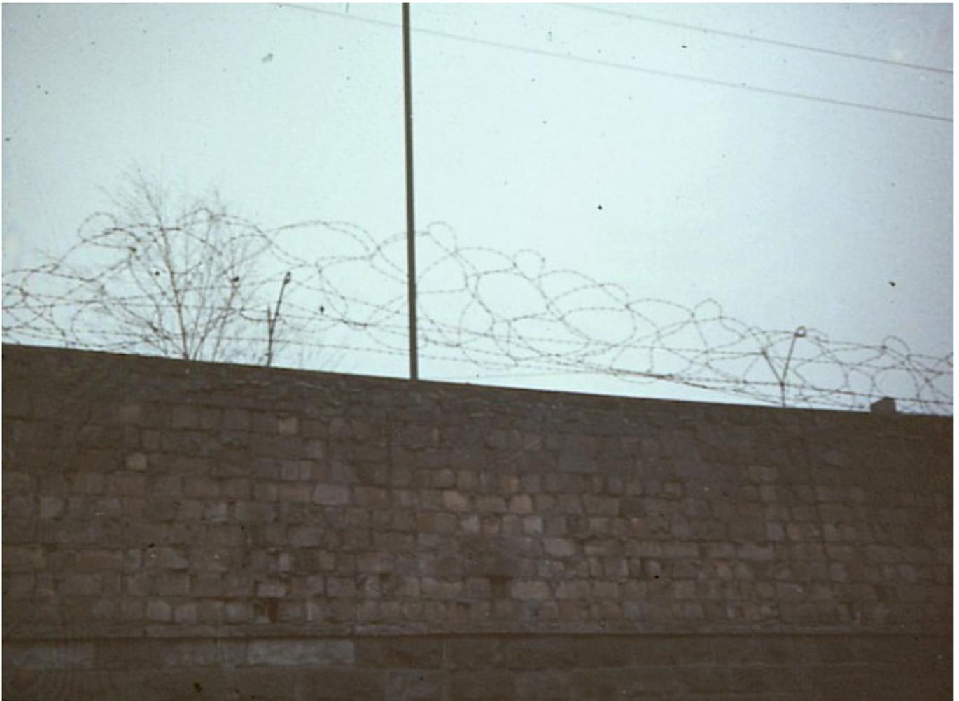
Grenzmauer an der Ostseite der Schillingbrücke am Spreeufer. Sie besteht aus einer Betonverbundmauer mit beidseitigen Abweisern.
