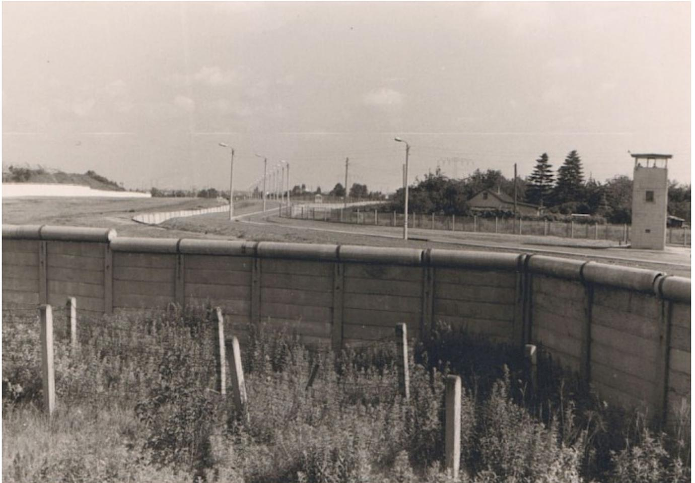
Am Neudecker Weg stehen ältere Stacheldrahtzaunreihen vor der neuen Grenzmauer, die aus Betonplatten und Rohraufgabe besteht. Im Grenzstreifen steht hinter einem Sperrgraben und der Lichttrasse ein Wachturm vor dem Hinterlandzaun.
