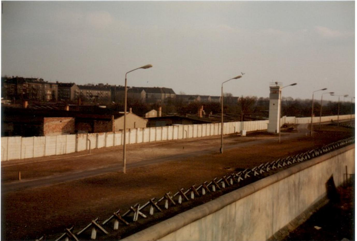
Ein Wachturm des Typs BT-9 im Grenzstreifen entlang der Kieffholzstraße. Hinter der Grenzmauer 75 sind die Fahrzeugsperrn, der Kontrollstreifen, die Grenzleuchten, der Signalzaun und die Hinterlandmauer sichtbar, die das Erscheinungsbild dieser späten Ausbauphase des Grenzstreifens prägen.
