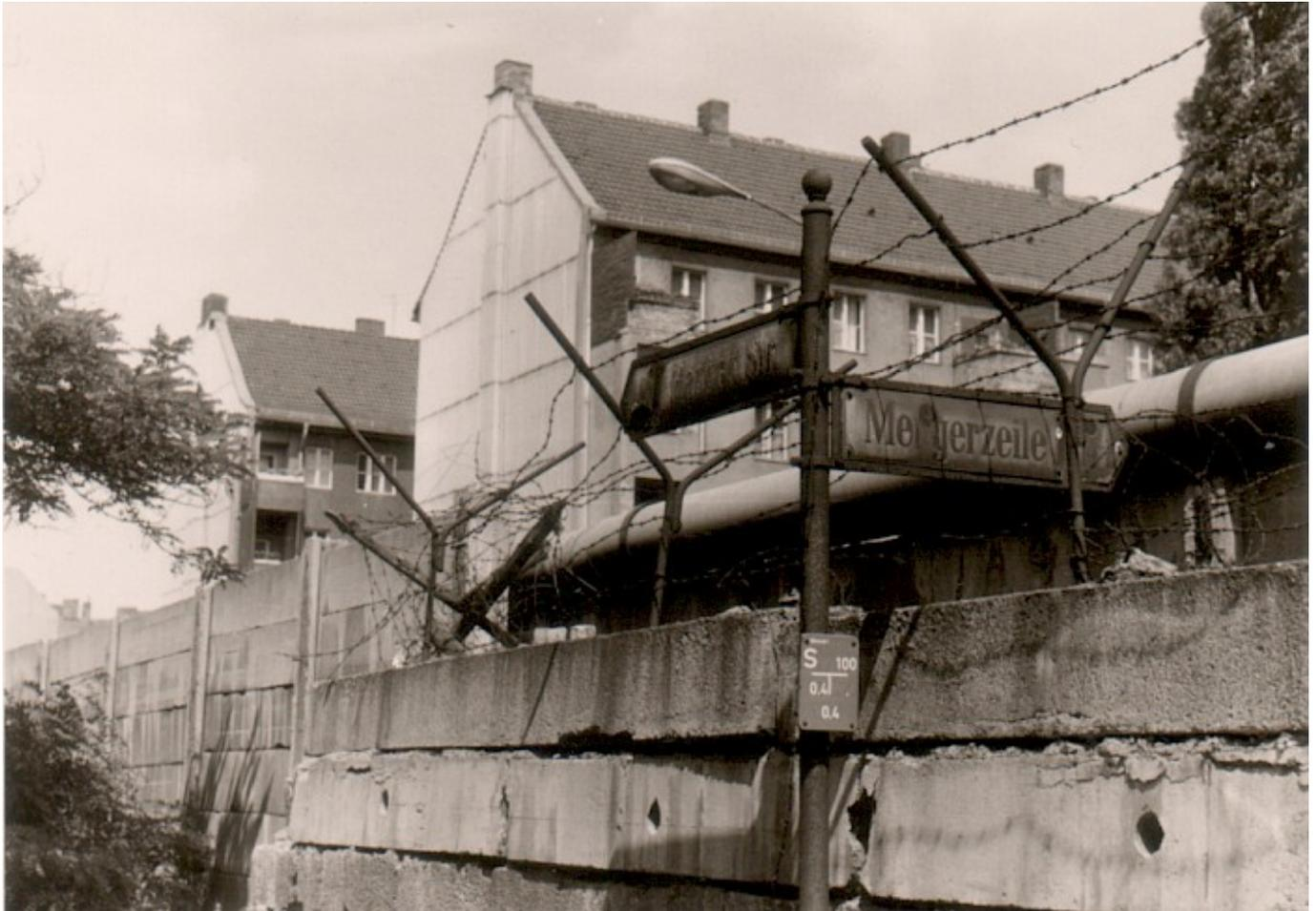
Die Berliner Mauer ist ein komplexes Sperrsystem mit zahlreichen Elementen, das beständig erweitert wird. Besonders in Stadtteilen, in denen die Wohnhäuser nah an der Grenze stehen wie hier zwischen Treptow und Neukölln, entsteht ein System mehrerer Mauern und Zäune, die zudem nach und nach ersetzt und ergänzt werden. Das Erscheinungsbild der Berliner Mauer ist daher in den ersten beiden Jahrzehnten sehr uneinheitlich und besteht aus älteren und moderneren Sperrelementen.
