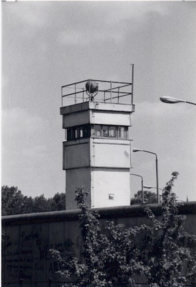
Wachturm vom Typ BT-9 aus quadratischen Betonelementen an der Lohmühlenbrücke zwischen dem West-Berliner Bezirk Neukölln und Treptow in Ost-Berlin. Auf dem Dach ist der Suchscheinwerfer erkennbar.
