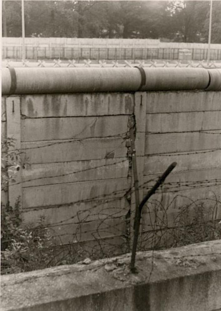
Hinter der alten Grenzmauer mit Stacheldraht-Abweisern ist eine neuere Variante einer Betonplattenmauer mit Rohrauflagen errichtet. Im Grenzstreifen dahinter stehen Fahrzeugsperrern und ein Postenbunker.
