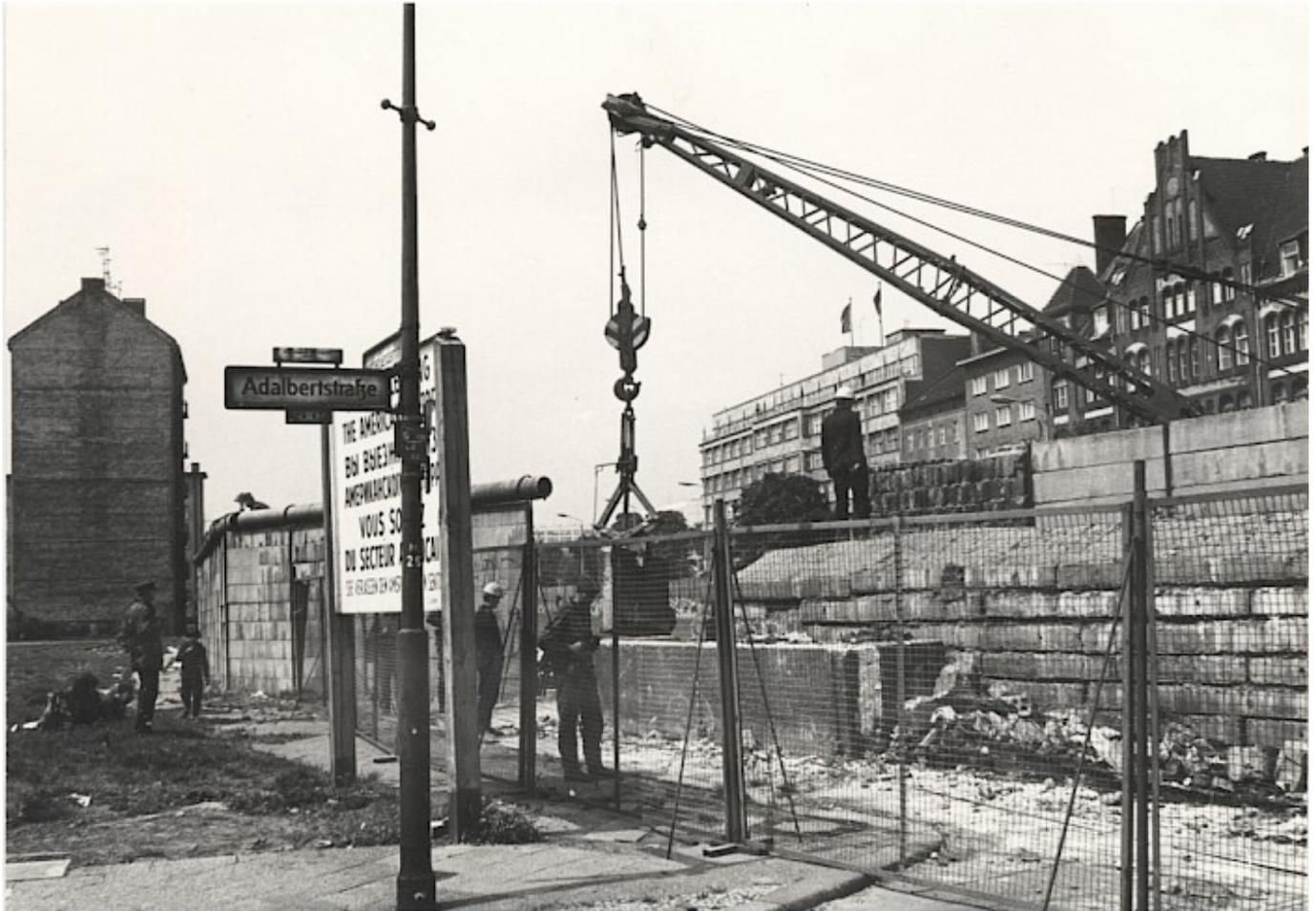
Die alte Grenzmauer aus Betonquadern und Hohlblocksteinen wird abgetragen und durch eine neuere Grenzmauer aus Betonplatten mit Rohraufgabe ersetzt. Der Abriss, der mit Hilfe eines Krans und Bauarbeitern ausgeführt wird, wird von Grenzsoldaten überwacht. Auf der West-Berliner Seite steht direkt vor der Grenzmauer das amerikanische Sektorenschild neben dem Straßenschild der Adalbertstraße. Die Berliner Mauer verläuft am Bethaniendamm zwischen den Bezirken Kreuzberg und Mitte.
