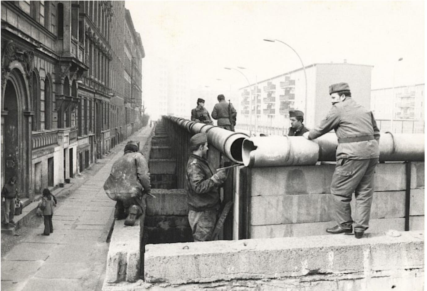
Unter gegenseitiger Aufsicht installieren Angehörige der Grenztruppen die Rohrauflage auf der neu errichteten Betonplattenmauer. Davor steht direkt am Bürgersteig zu West-Berlin die ältere Mauer, von der bereits der Stacheldraht entfernt worden ist. Diese wird in den kommenden Jahren komplett entfernt. Die neue Mauer steht daher meist einige Meter zurückgesetzt von der eigentlichen Sektorengrenze.
