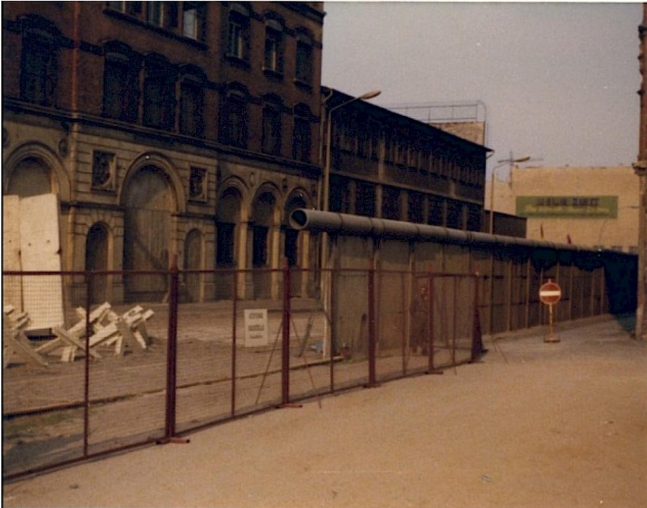
1976 wird im Bereich der Zimmerstraße, zwischen Niederkirchner Straße und Friedrichstraße, damit begonnen, die Reste der alten Grenzmauer aus Betonplatten zu beseitigen und die neue Grenzmauer 75 aus Betonfertigteilen zu errichten. An der Stelle der alten Mauer wird übergangsweise ein 400 Meter langer mobiler Sicherheitszaun errichtet, der den Abstand zu den Wohnhäuser auf eine Breite von 1,50 bis 2 Meter verringert. Ein Grenzsoldat bewacht den Bereich zwischen Zaun und Grenzmauer.
