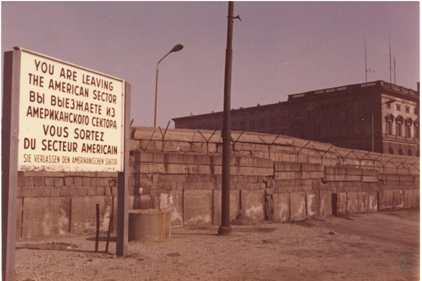
Vor der Berliner Mauer steht ein amerikanisches Sektorenschild in unmittelbarer Nähe des Berliner Abgeordnetenhauses. Die Grenzmauer ist als Verbundmauer aus verschiedenen Betonelementen zusammengesetzt und mit Stacheldrahtabweisern versehen, dahinter steht eine weitere geschichtete Betonmauer.
