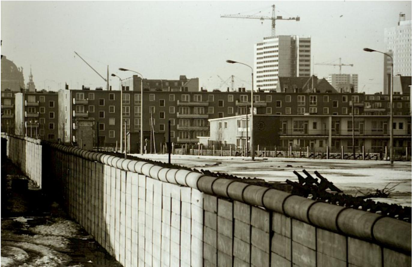
Grenzstreifen mit Fahrzeugsperren, Grenzleuchten und als Sicherung Richtung Ost-Berlin ein Zaun an Betonpfosten sowie vertikal aufgestellte Betongitterplatten zur Verhinderung von Fluchtversuchen mit Fahrzeugen. Im Hintergrund ist die Neubebauung der Fischerinsel mit der Errichtung von Hochhäusern im Gange.
