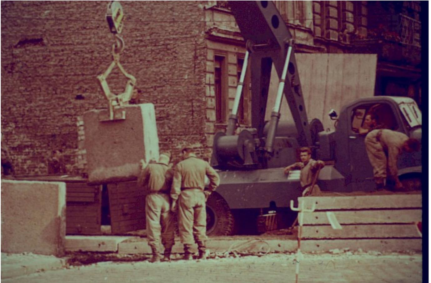
Ein Kran hebt Betonplatten aus der Grenzmauer an der Wolliner Straße, die dort durch massive Betongitterplatten in horizontaler Schichtung ersetzt werden.
