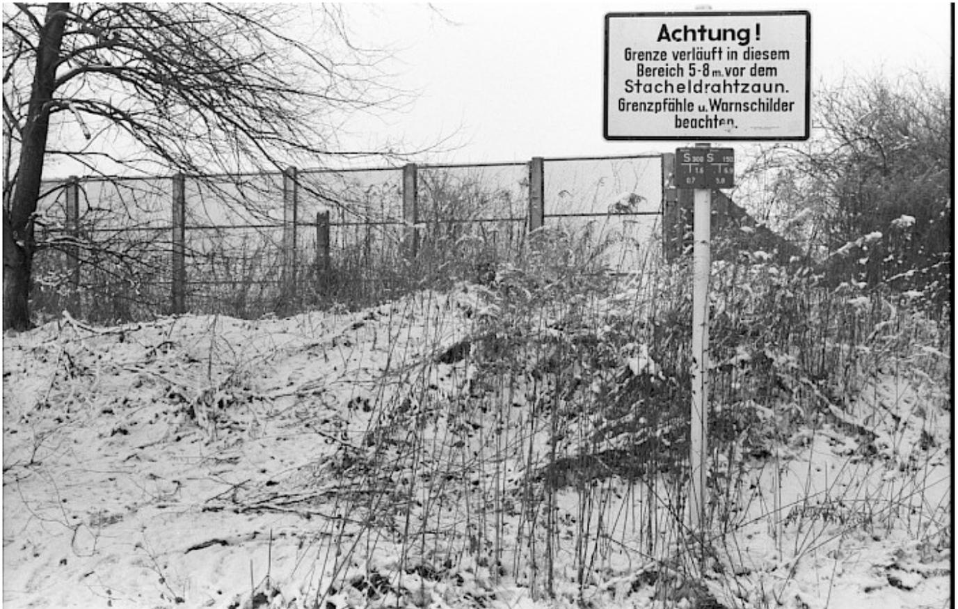
Auf einem Warnschild steht: "Achtung! Grenze verläuft in diesem Bereich 5-8 m. vor dem Stacheldrahtzaun. Grenzpfähle u. Warnschilder beachten." Dahinter verläuft der hier als vorderes Grenzelement dienende Streckmetallzaun vom Typ "Grenzzaun I" mit einer Höhe von 2,90 Metern im Schnee.
