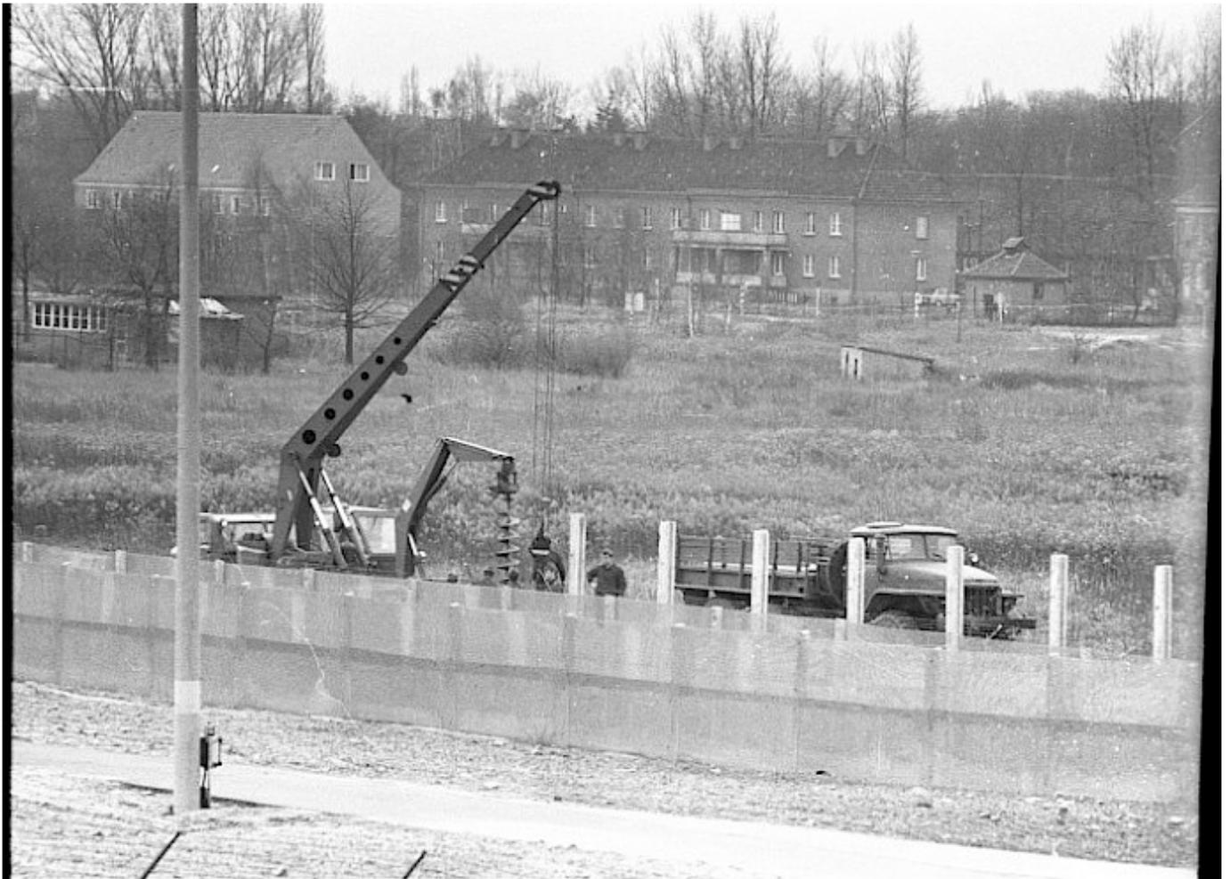
Bauarbeiten an der Hinterlandmauer am Finkenkruger Weg. Die Betonpfeiler der Hinterlandmauer werden durch einen Bautrupp mit Hilfe eines Krans aufgestellt. Daneben stehen weitere Betonteile in einem Transporter bereit. Vor der Hinterlandmauer im Grenzstreifen verläuft ein Signalzaun, im Hintergrund auf DDR-Gebiet sind Wohnhäuser sichtbar.
