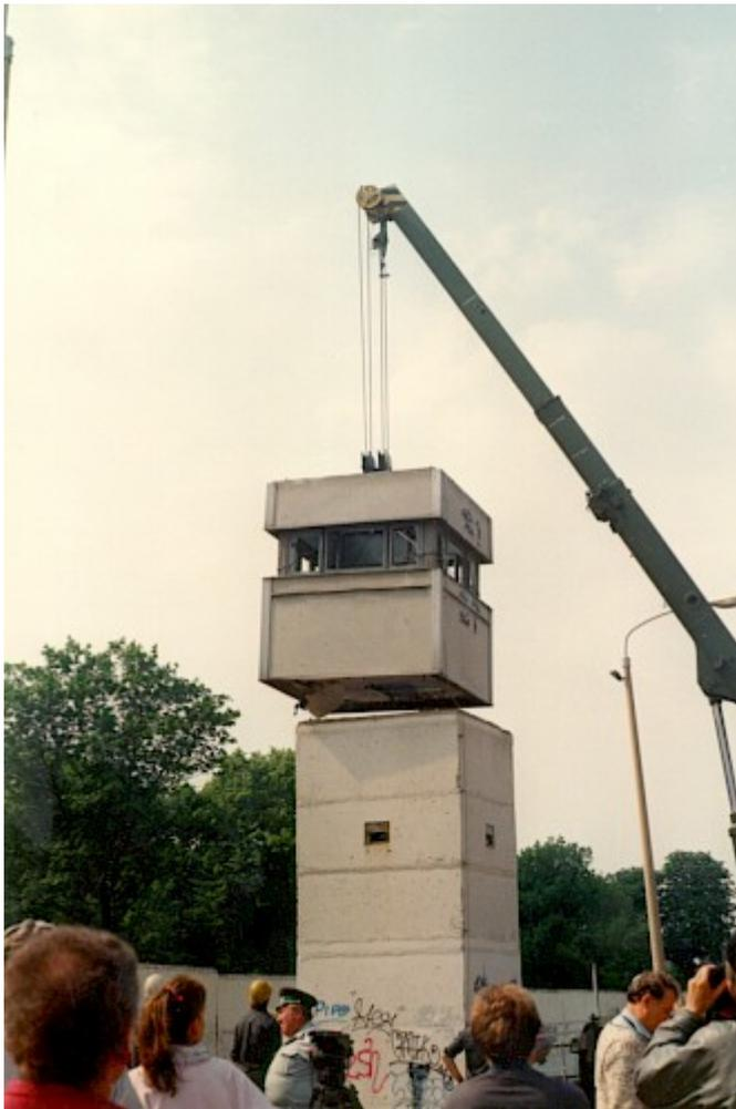
Fahrzeugkran beim Entfernen der Beobachtungskanzel eines Wachturms Typ BT-9 beim Beginn des offiziellen Abbaus der Berliner Mauer.
