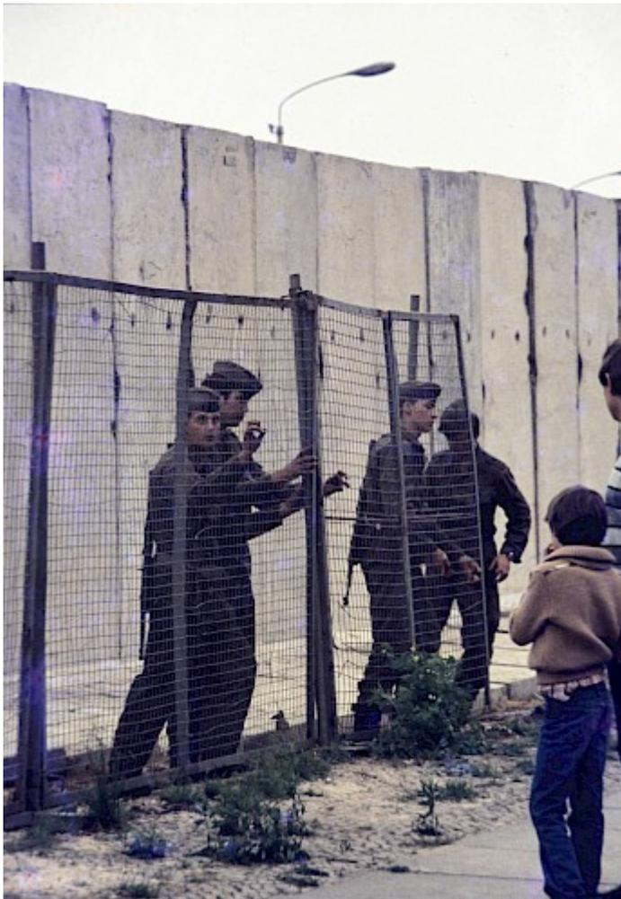
Die Grenzsoldaten bauen die provisorischen Wellengitterzäune ab. Nachdem die L-Elemente der Grenzmauer 75 aufgestellt wurden, wird der mobile Sicherungszaun nicht mehr als vorderes Sperrelement gebraucht.
