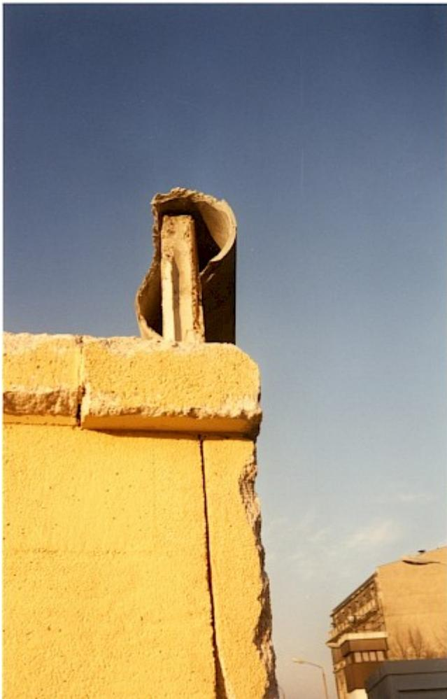
Untersicht auf den Übergang von Panzermauer zur Grenzmauer 75 auf der Nordwestseite des Brandenburger Tores. Die Rohrauflage ist zum Teil beschädigt.
