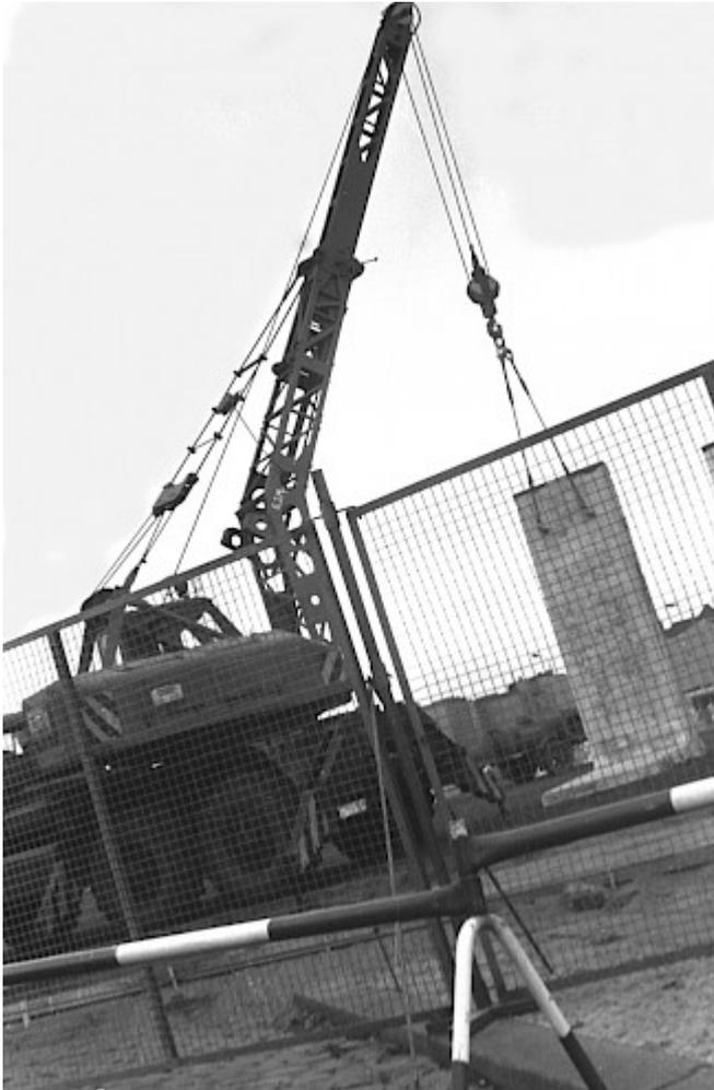
Hinter einem mobilen Sicherungszaun wird ein Mauerelement mit Hilfe eines Krans angehoben.
