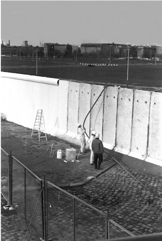
Angehörige des Bautrupps beim Ausbau der Grenzmauer. Ein mobiler Sicherheitszaun steht vor der Baustelle. Hinter der Grenzmauer liegt der Grenzstreifen mit Fahrzeugsperrern.
