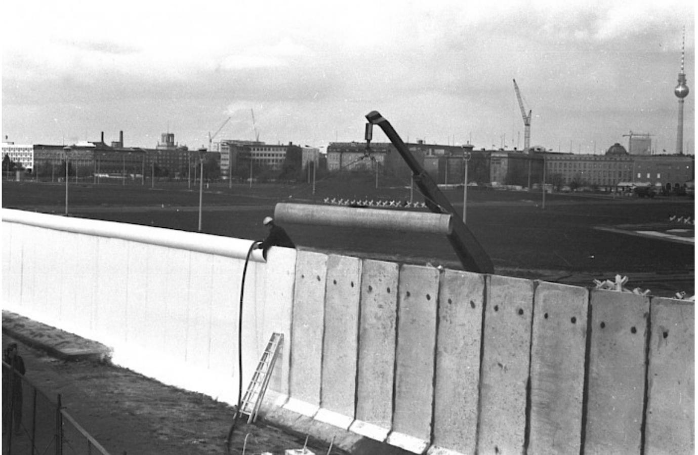
Ein Angehöriger des Bautrupps befestigt eine Rohraufgabe auf der Grenzmauer. Daneben befindet sich ein Kran. Vor der Baustelle stehen ein mobiler Sicherheitszaun und ein Grenzsoldat. Hinter der Grenzmauer liegt der Grenzstreifen mit Fahrzeugsperrern. Im Hintergrund ist der Fernsehturm sichtbar.
