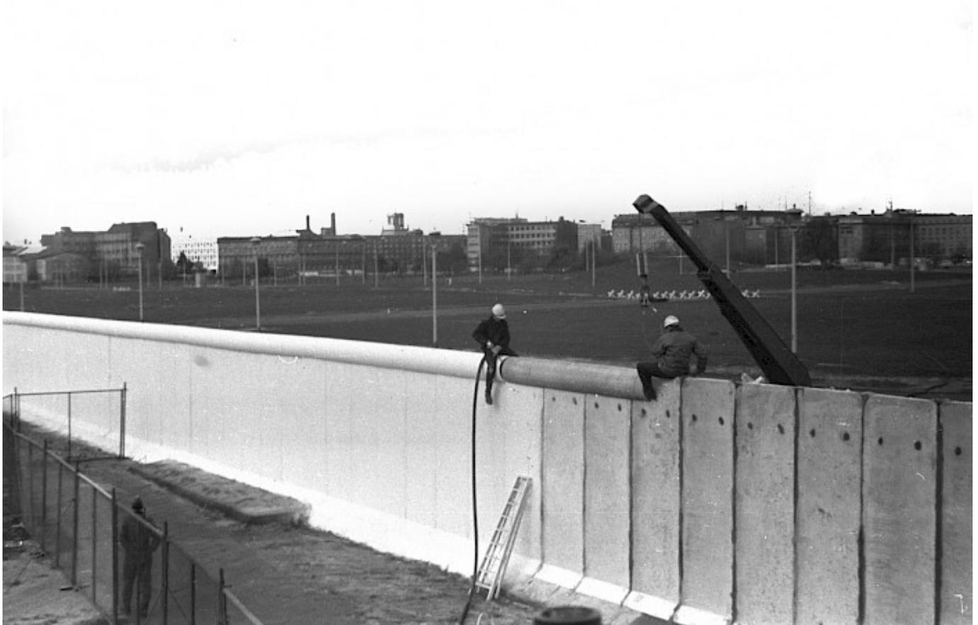
Angehörige des Bautrupps befestigen eine Rohrauflage auf der Grenzmauer. Daneben befindet sich ein Kran. Vor der Baustelle steht ein mobiler Sicherungszaun und ein Grenzsoldat. Im Hintergrund ist der Grenzstreifen mit Fahrzeugsperrern sichtbar.
