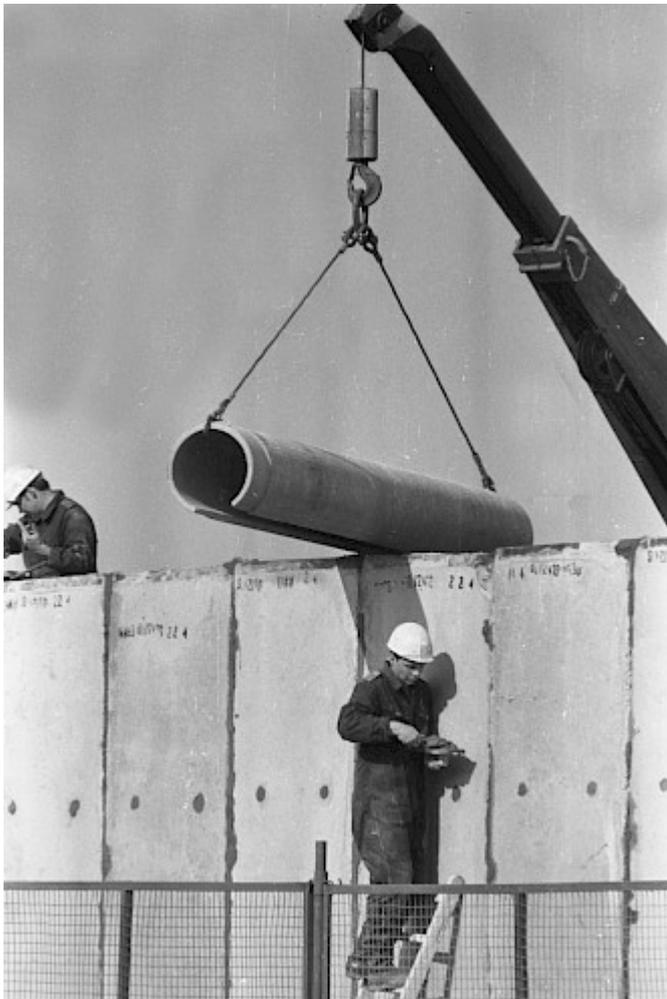
Ein Angehöriger des Bautrupps verputzt die Mauerelemente, während er auf einer Leiter steht. Über seinem Kopf schwebt eine Rohrauflage, die an einem Kran hängt. Ein weiterer Bauarbeiter lehnt an der Grenzmauer. Vor der Baustelle befindet sich ein mobiler Sicherungszaun.
