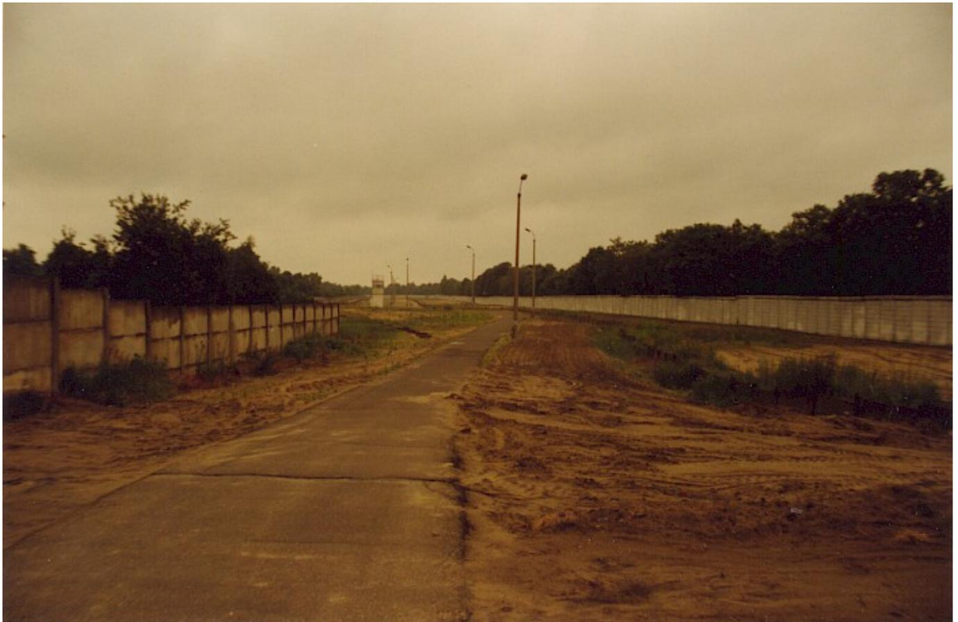
Der Grenzstreifen besteht aus einem Postenweg, der von Grenzleuchten gesäumt ist und beidseitig von Betonplattenmauern eingerahmt ist. Im Hintergrund steht ein kurzer Wachturm des Typ BT-9, hier aber nur mit drei Betonelementen als Turmschaft.
