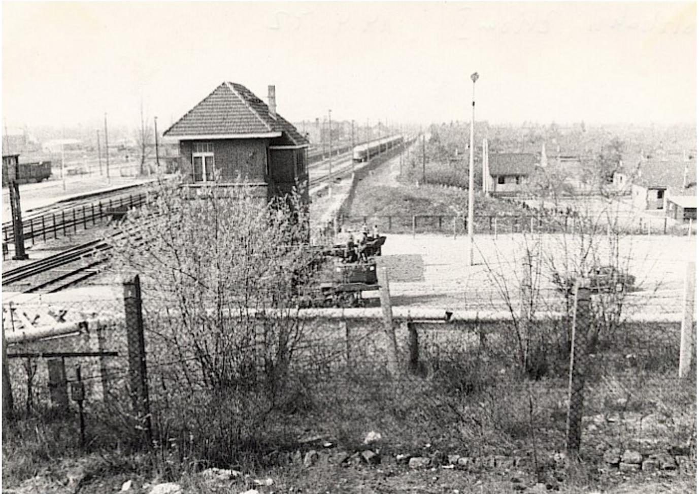
Beginn der Baumaßnahmen für die Grenzmauer am Bahnhof Staaken. Im Vordergrund ist eine Betonplattenmauer mit einem davor stehenden Grenzzaun sichtbar. Neben dem Stellwerksgebäude steht ein Baufahrzeug mit einem Bautrupp.
