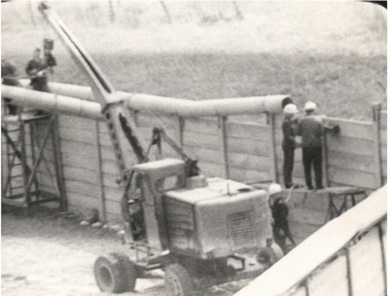
Angehörige des Bautrupps erweitern mit Hilfe eines Baufahrzeugs die Hinterlandmauer um Rohrauflagen.
