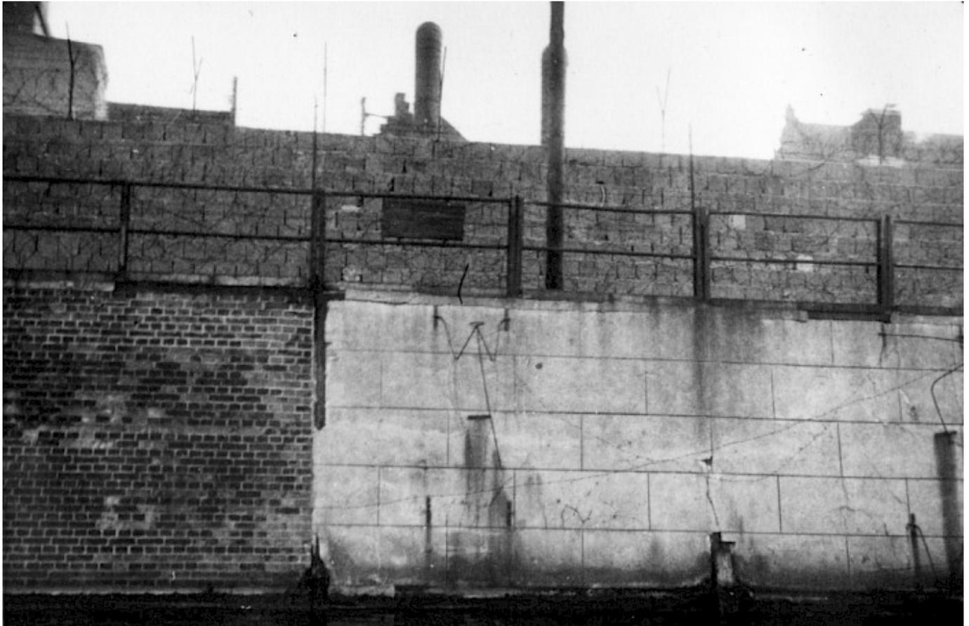
Die Grenzmauer am Ostufer der Schillingbrücke. Sie besteht aus einer Betonverbundmauer mit beidseitigen Abweisern und Stacheldraht.
