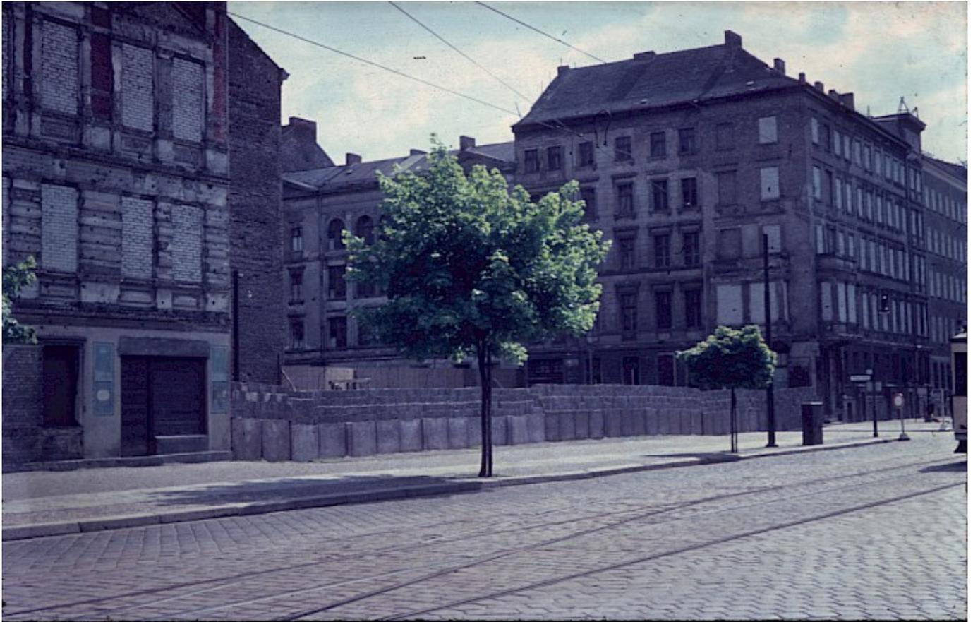
Grenzmauer in der Bernauer Straße/Wolliner Straße. Diese besteht aus einer Betonverbundmauer mit einseitigen Abweisern und dahinter stehenden Sichtblenden. Die Grenzmauer sperrt die Straße zwischen den vermauerten Grenzhäusern.
