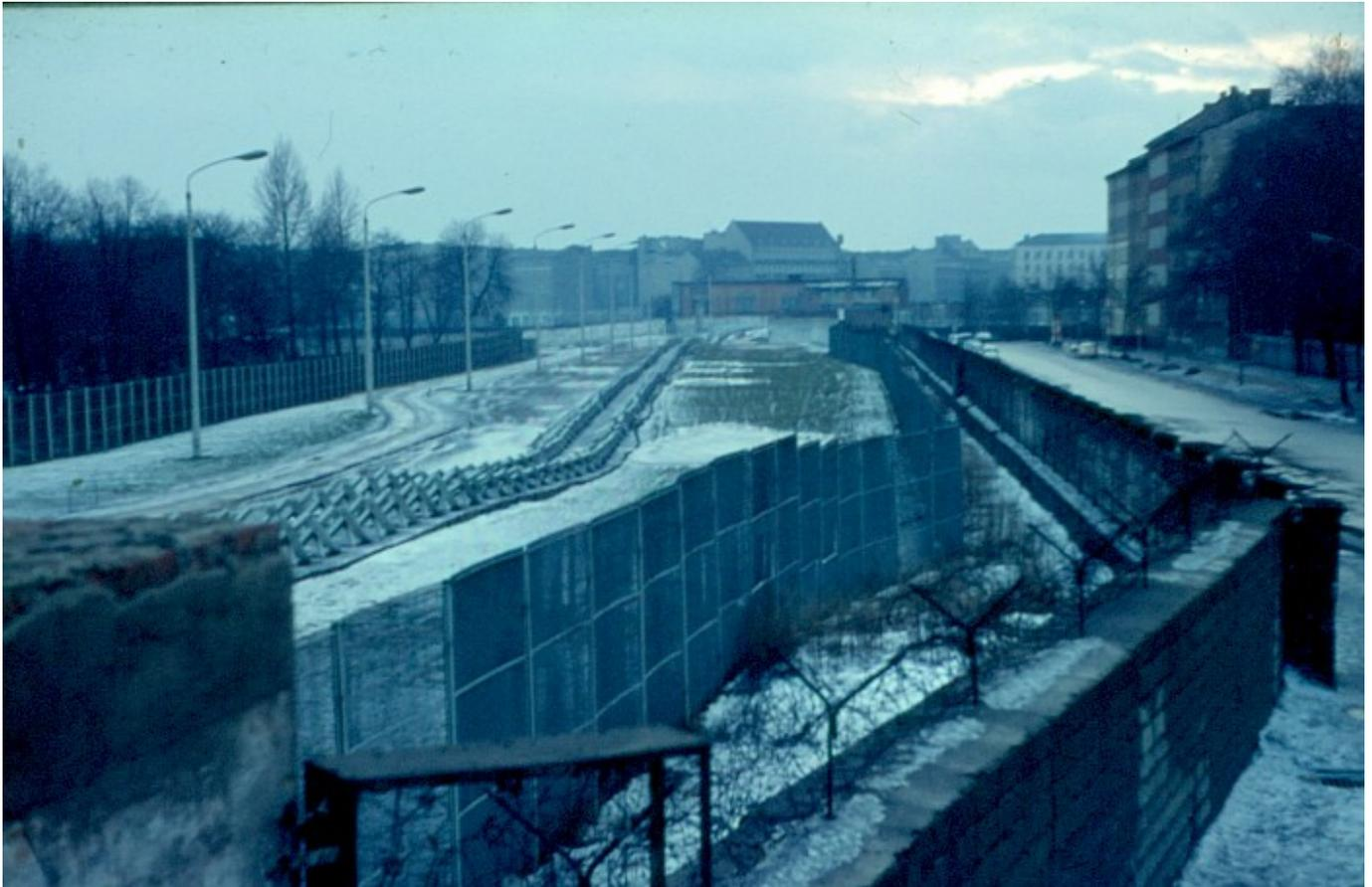
Blick von der Aussichtsplattform an der Ackerstraße auf den Grenzstreifen mit Hinterlandzaun, Grenzleuchten, Fahrzeugsperrern, Sichtblenden, Grenzmauer mit aufgesetzten Stacheldrahtabweisern.
