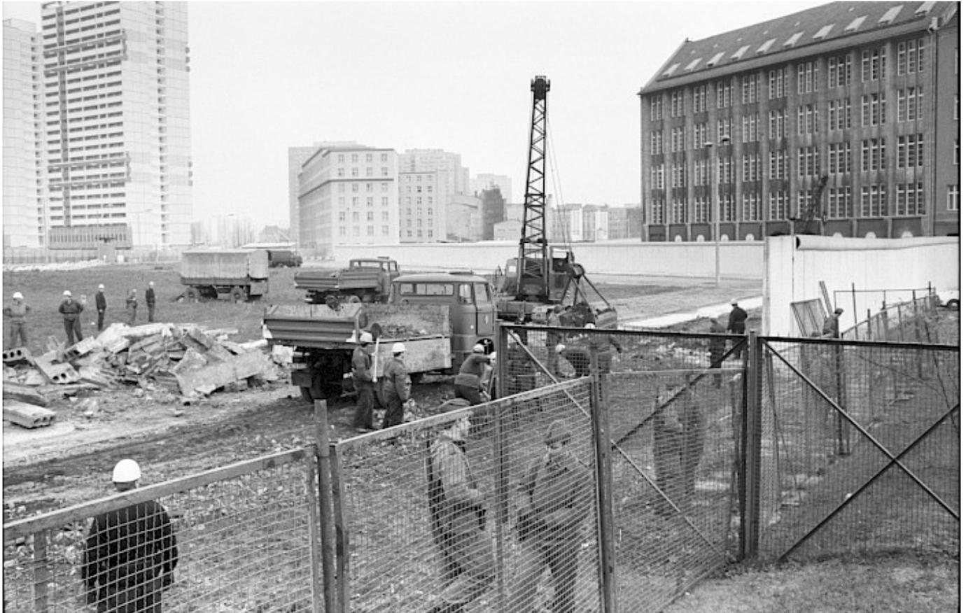
Die abgerissenen Reste der alten Grenzmauer werden von einem Baudrupp mit Hilfe eines Krans auf ein Baufahrzeug geladen, um einen weiteren Teil der Grenzmauer 75 aufzubauen. Ein Teil der Grenzmauer 75 ist bereits fertig gestellt. Grenzsoldaten hinter dem mobilen Sicherheitszaun beobachten das Geschehen.
